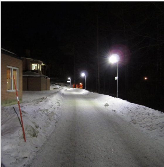
Bild efter installation
