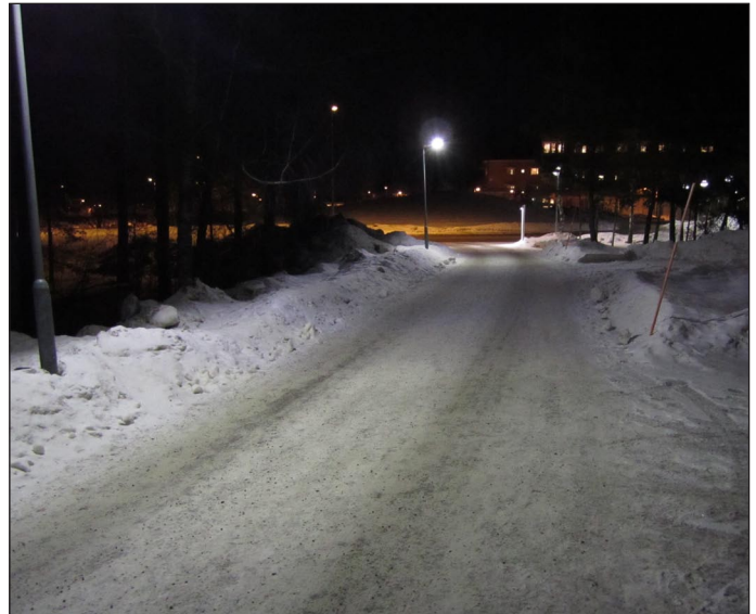
Bild efter installation
