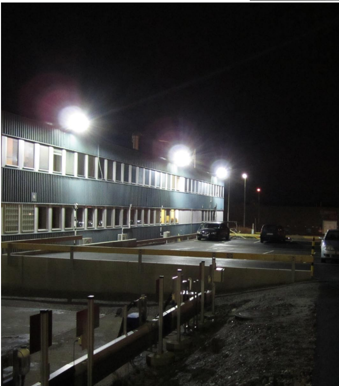
Bild efter installation
